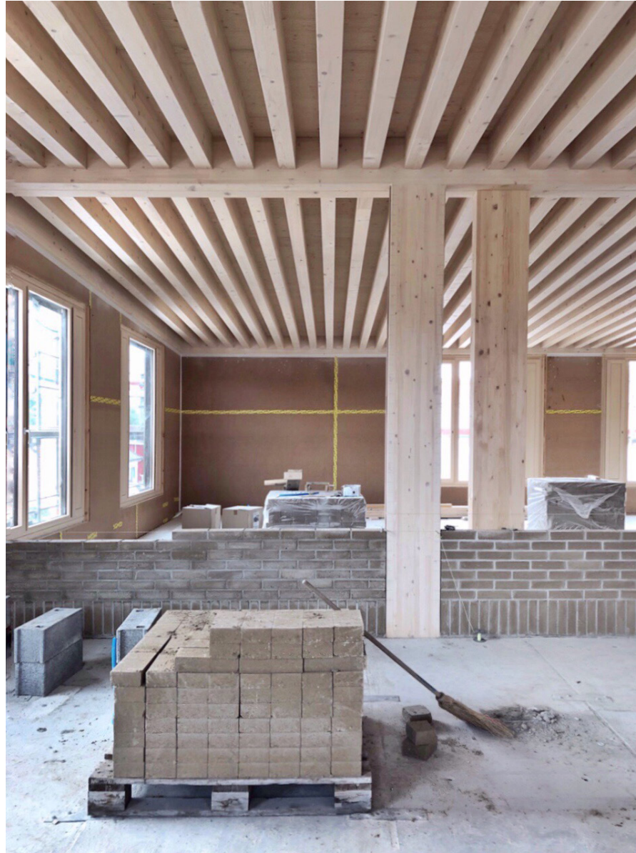
CONSTRUCTION DES MURS - OCTOBRE 2019
